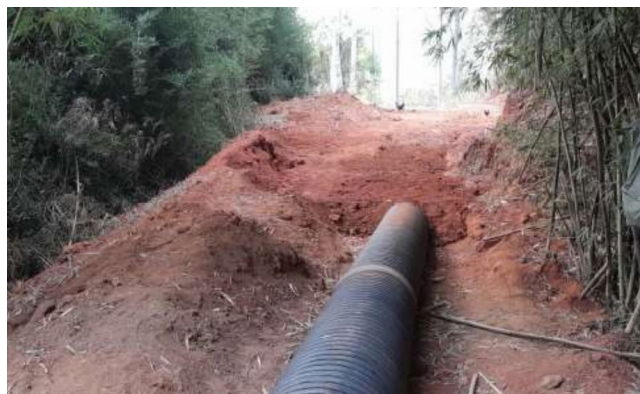
Tubulação usada para os interceptores da margem esquerda do Rio Piranga (crédito da foto: divulgação do DMAES).
