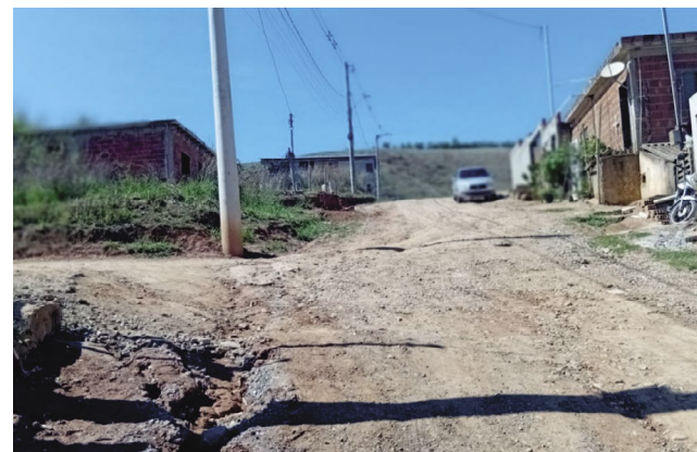
2 Este trecho ainda precisa de drenagem pluvial e rede de abastecimento de água (crédito da foto: Ricardo Motta/Líder Notícias).
