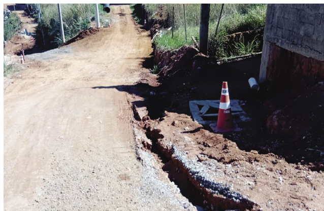
1 Sistema de drenagem começou a ser construído em maio na Rua Paulo Moreira Brandão, localizada no Bairro Nova Copacabana (crédito da foto: Ricardo Motta/Líder Notícias).
