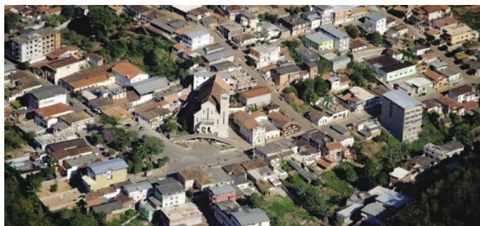
O município de São Miguel do Anta caminha a construção da ETE (crédito da foto: Folha da Mata/Viçosa).
