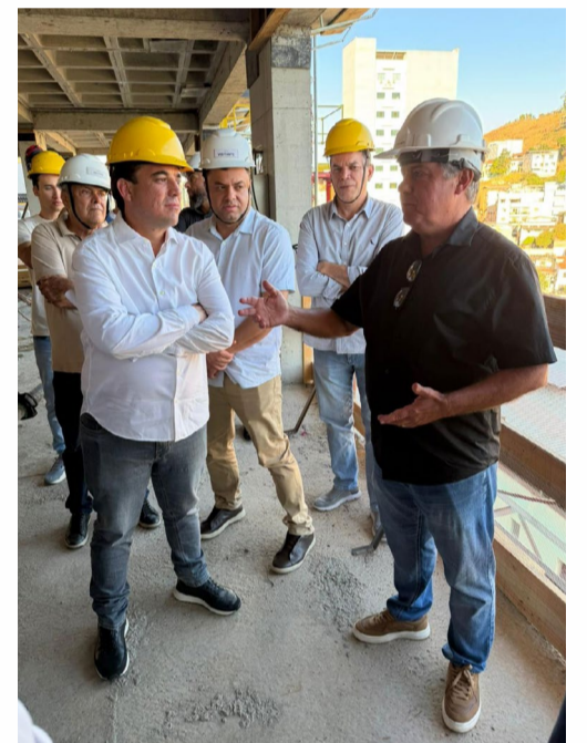
Visita às obras de expansão do HAG, na semana passada (crédito da foto: divulgação AssCom).
