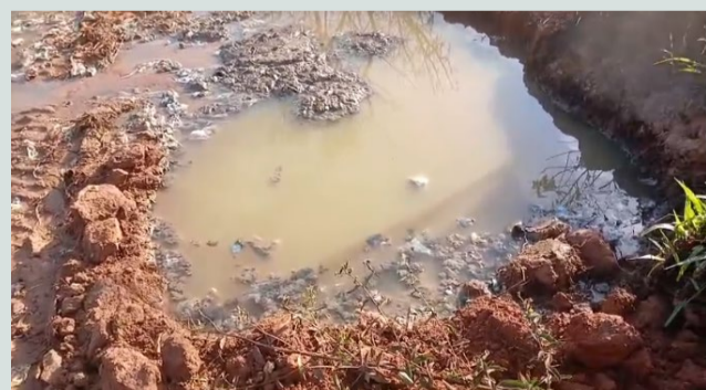
Esgoto do rompimento da rede da unidade prisional polui o córrego e lagoas do Passa-Cinco (crédito da foto: print de vídeo divulgado em redes sociais).
