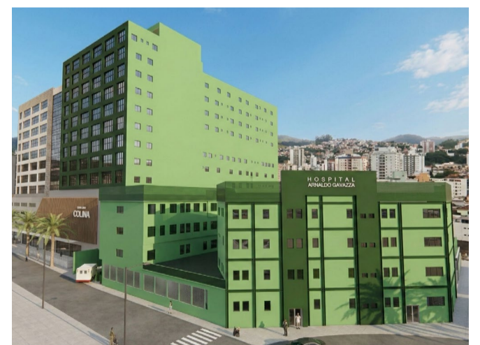
Projessão de Ampliação do HAG colocará Ponte Nova na liderança do atendimento à saúde da Zona da Mata mineira (crédito da imagem: divulgação do HAG).
