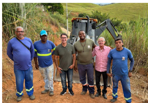
1 Prefeito Dr. Milton (Avante) e o vereador Zé Osório (PSB), em 04 de maio de 2026, com trabalhadores e máquina para começar o serviço de drenagem, prometido no final de março deste ano (crédito da foto: divulgação)
