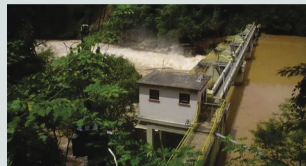
Usina Hidrelétrica da Brecha, em Guaraciaba (MG) teve sua construção iniciada em 1910 (crédito da foto: Wesley Souza Oficial)
