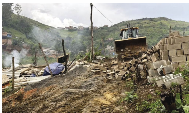
Casas foram demolidas por estarem em APP (crédito da foto: Jornal Geraes)
