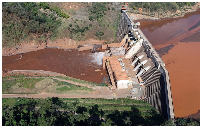
Usina Risoleta Neves (Candonga), entre Santa Cruz do Escalvado e Rio Doce, continua inoperante devido ao acúmulo de rejeitos da mineradora Samarco (crédito da foto: UHE Risoleta Neves)
