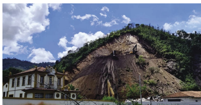
Deslizamento do Morro da Força em Ouro Preto destruiu casarão histórico, em 2022 (crédito da foto: Nizea Coelho)
