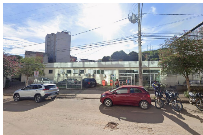
O prédio onde funciona a Policlínica Milton Campos se demolindo e o terreno devolvido (crédito da foto: reprodução Google Street View)
