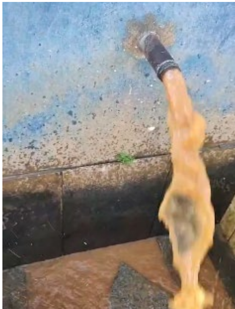
O hidrojato do caminhão do DMAES desentupiu a canalização (crédito da foto: arquivo AmaCopa)
