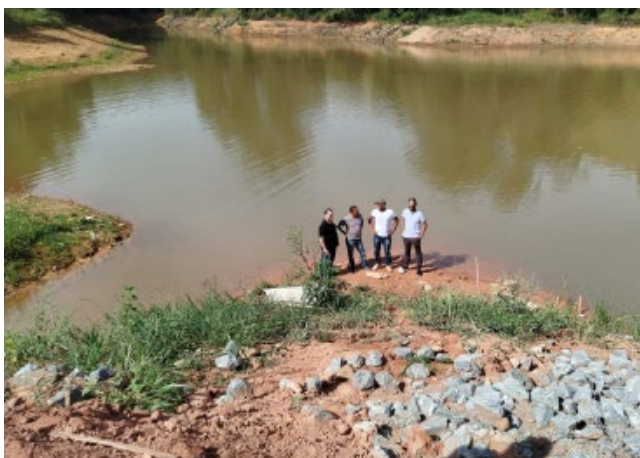
2 Vereadores Marcinho de Belim (PDT), Careca Totinho (Avante), Gustavo de Fizica (MDB) e Thaffarel do Povo (PSB) perto do vertedouro (ladrão) que fica mais de cinco metros abaixo do reforço da barragem (crédito da foto: Diego Simam/Líder Notícias)
