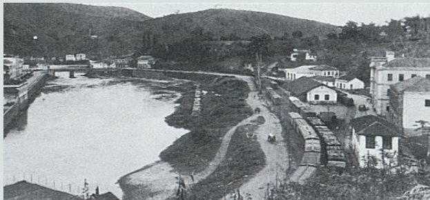
A estação da Leopoldina de Ponte Nova, com o morro ao fundo, onde está a estação da Central. Acervo Hugo Caramuru. Disponível em: http://www.estacoesferroviarias.com.br/efcb_mg_pontenova/pontenova-central.html .
