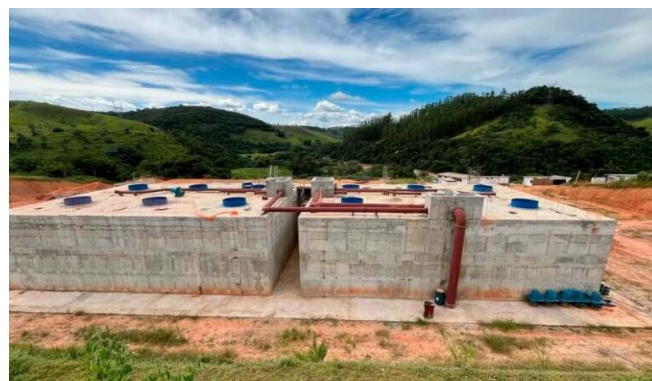
Estação de Tratamento de Esgoto/ETE (abaixo da Rasa) em construção (crédito da foto: Gabriel Chaves, em fevereiro de 2025)
