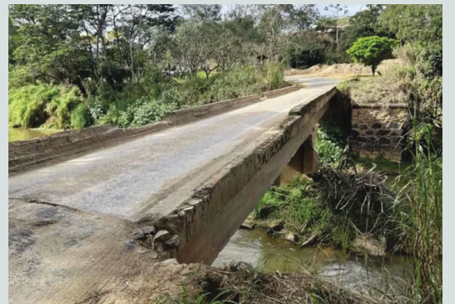
Estrutura atual (precária) da ponte sobre o Rio Casca dá cesso ao município de Santo Antônio do Grama: nova estrutura será construída ao lado (crédito da foto: divulgação do DER-MG)
