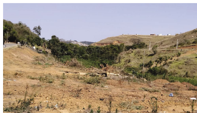
Ações para o início da terraplenagem provocou desmatamento (crédito das foto: Redes Sociais)
