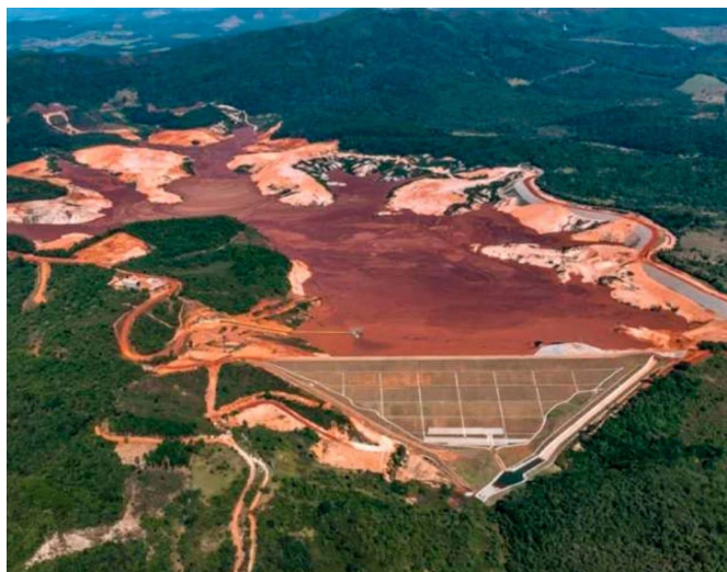
MP acompanha de perto a descaracterização da Barragem Forquilha III, da Vale S.A. (crédito da foto: divulgação Revista Mineração)
