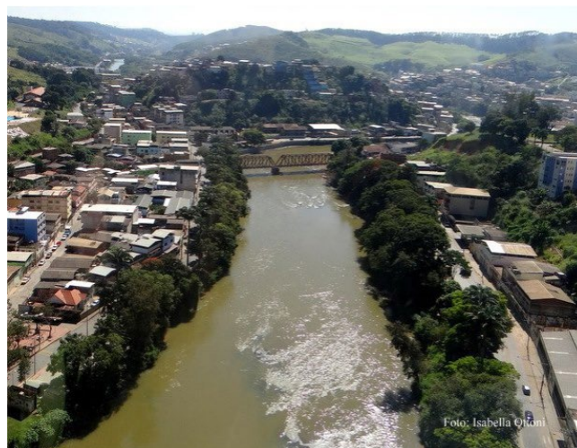
Os atletas percorrerão as margens direita e esquerda do Rio Piranga, no perímetro urbano
