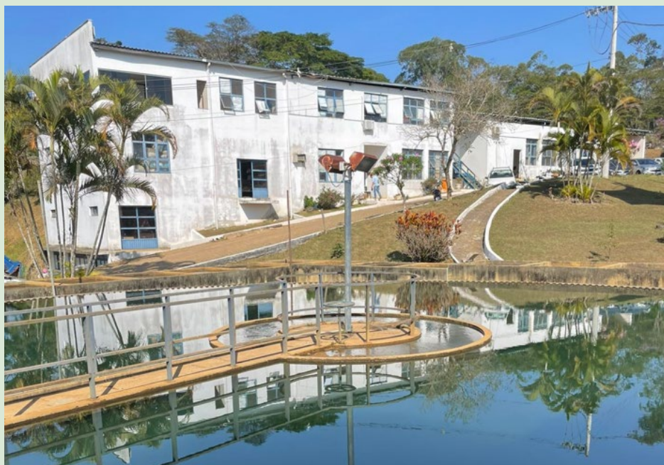
Estação de Tratamento de Água 1, do Saae (crédito da foto: Univiçosa)
