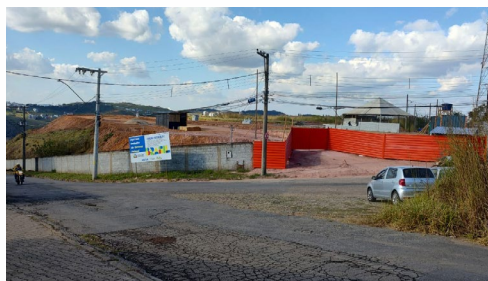
2 As obras para a construção moradias continuam (crédito da foto: Diego Si-man/Líder Notícias)
