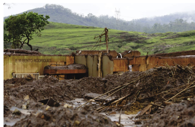
Escombros de uma escola em Bento Rodrigues, em Mariana depois do rompimento da Barragem de Fundão da mineradora Samarco, em novembro de 2015 (crédito da foto: Agência Brasil)
