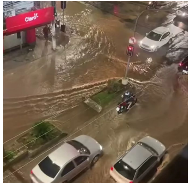
As chuvas provocam inundações em Palmeiras, depois da construção do canteiro central da Avenida Francisco Vieira Martins (crédito da foto: print de vídeo de mídia digital)
