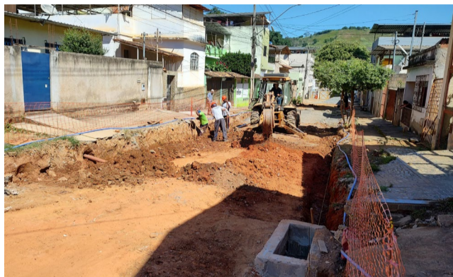
O ritmo das obras na Rua Nair Augusta Pires, na Vila Oliveira, agrada aos moradores que sofreram com os problemas durante mais de 03 anos
