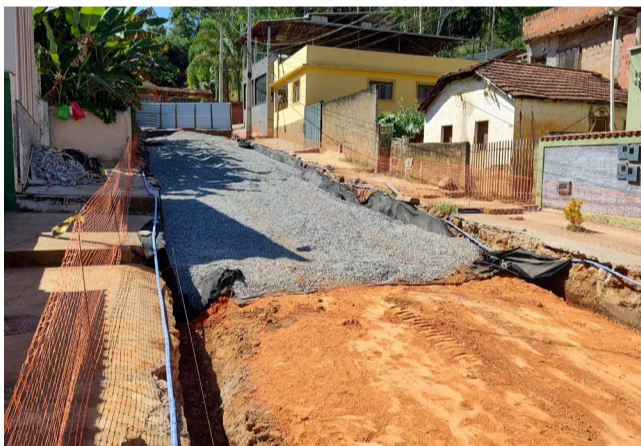
A obra será realizada em trechos, alternadamente para evitar transtornos
