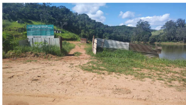
Placa indicativa da obra que está sendo realizada pela Engenharia Soluções, no valor de R$1.850.000,00
