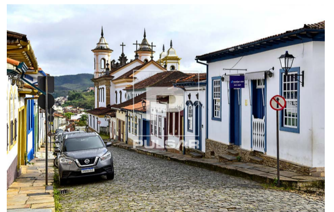
O município de Dom Silvério recebeu cerca de R$ 175 mil para saneamento básico (água e esgoto) do CBH Piranga
