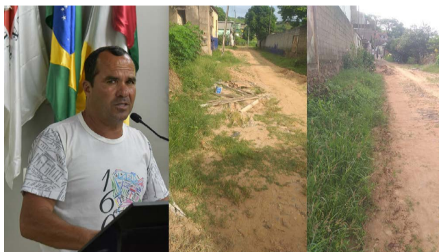
André Pessata (Podemos) mostra situação das vias danificadas pelas obras realizadas para possibilitar o tratamento de esgoto, em Ponte Nova
