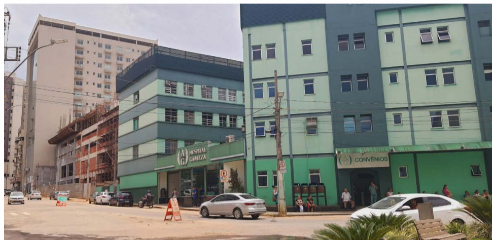
A construção do shopping pode ter isenção de impostos, mas ajuda na expansão do Hospital Arnaldo Gavazza Filho
