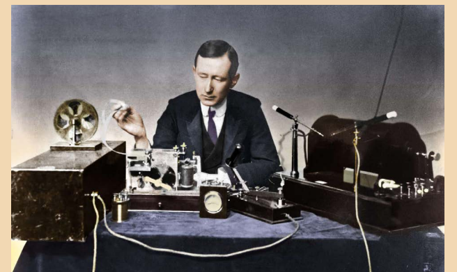
📍 Marconi com aparelho típico, incluindo transmissor de faísca com bobina de indução de 10 polegadas (à direita), tinta Morse e chave "gafanhoto" no centro. (Crédito da fotografia: Getty images)
