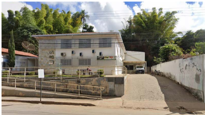
Unidade Básica de Saúde (UBS) de Cajuri continua alvo do Ministério Público e da Justiça por falta de acessibilidade e de condições sanitárias precárias
