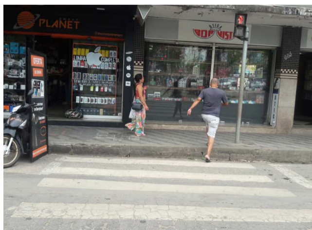
Falta de rampa de acessibilidade no passeio da Avenida Francisco Vieira Martins quase esquina com Avenida Dr. Otávio Soares (Palmeiras)
