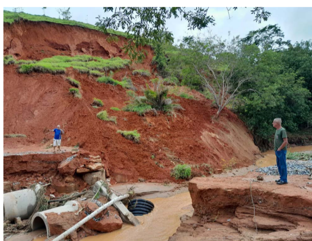
Provavelmente a região do Dioguinho tenha recebido uma tromba d'água pelo alto nível de destruição
