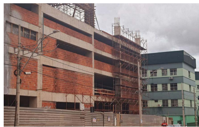
Com a construção do novo prédio o HAG poderá ter uma laje para novos leitos
