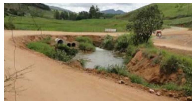
Trecho em que será construída a ponte sobre o Córrego Turvão
