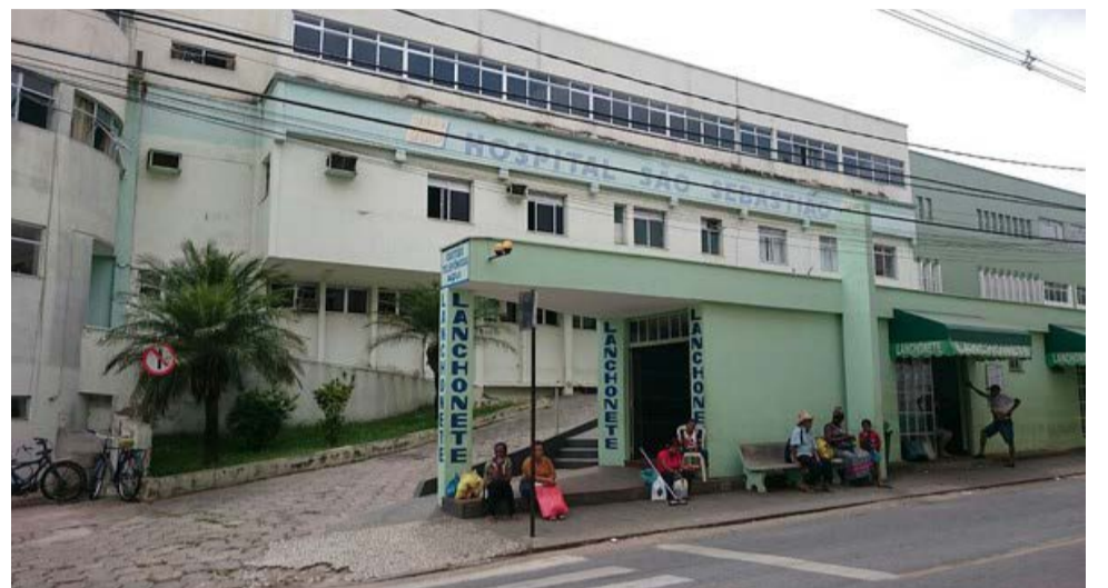
Hospital São João Batista em Viçosa
