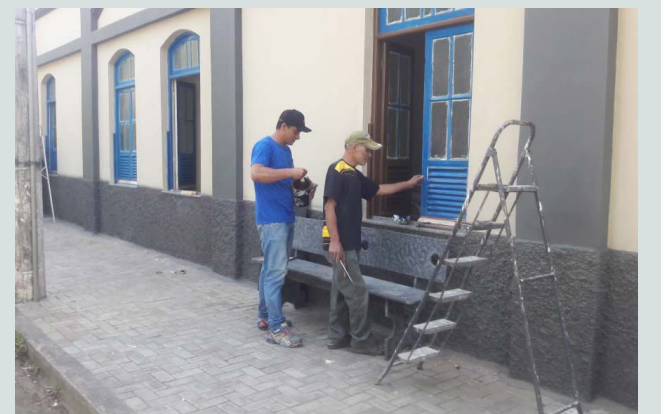
Darilson Fabiano e Antônio Marcos Gomes em ação na restauração e pintura do Asilo Municipal
