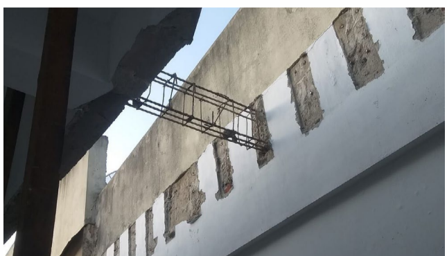
As obras proporcionarão a construção de segundo pavimento e instalação de elevador
