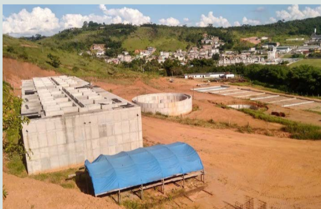
As obras da ETE-Barrinha completam 09 anos e ainda falta muito para terminar
