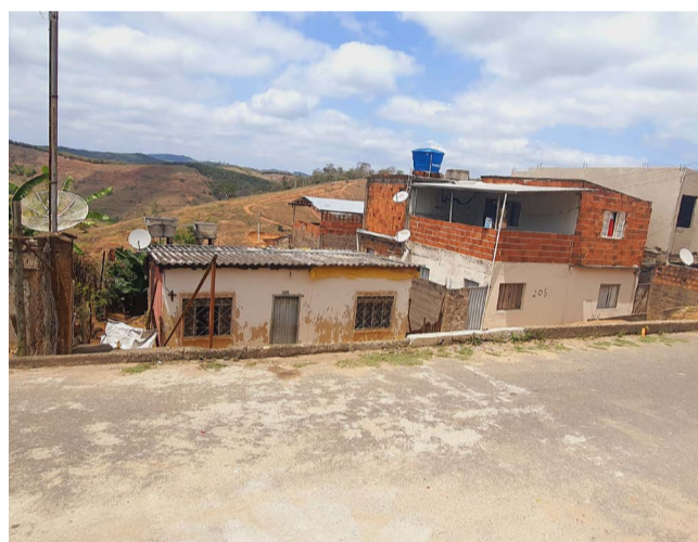
Rua Tapajós, no Bairro São Pedro, apresenta desnível
