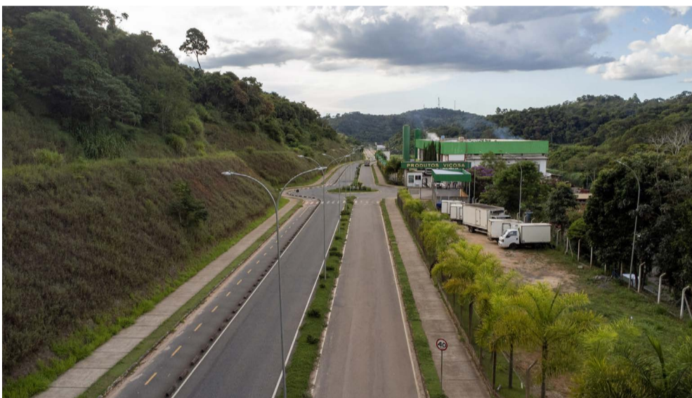
Aproximadamente mais de 600 pessoas já se inscreveram para correr em Viçosa, passando por dentro do campus da Ufv
