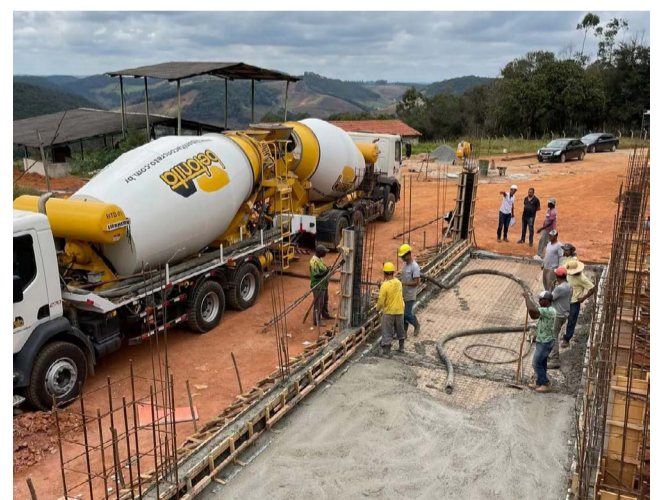
Operários constroem a UTCL de Guaraciaba, para melhor acondicionamento do RSUR
