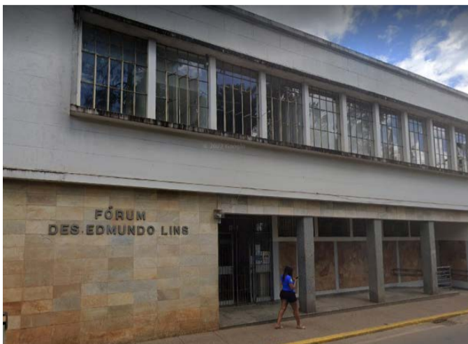
O Fórum Edmundo Lins, de Itabirito, foi atingido por enchente em 2020 e tornou-se obsoleto
