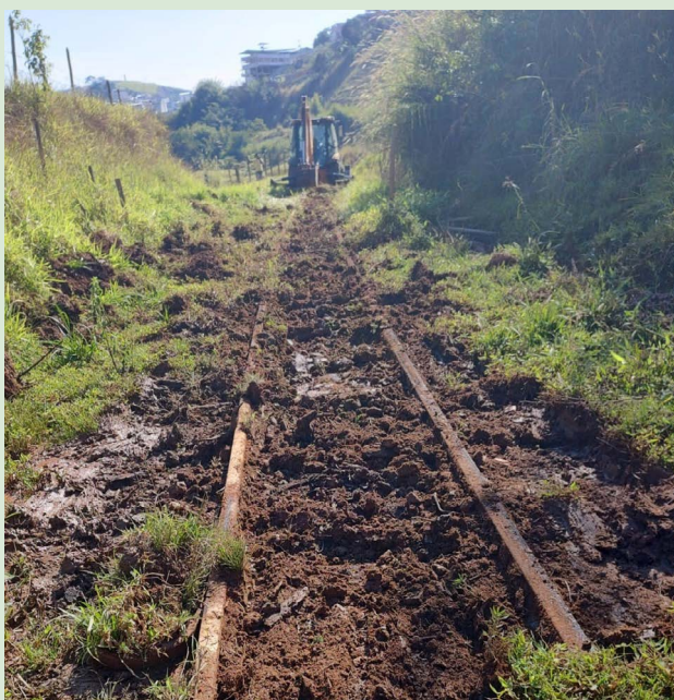
Maquina retroescavadeira da Sedru começou a limpeza na terça-feira, 13/06
