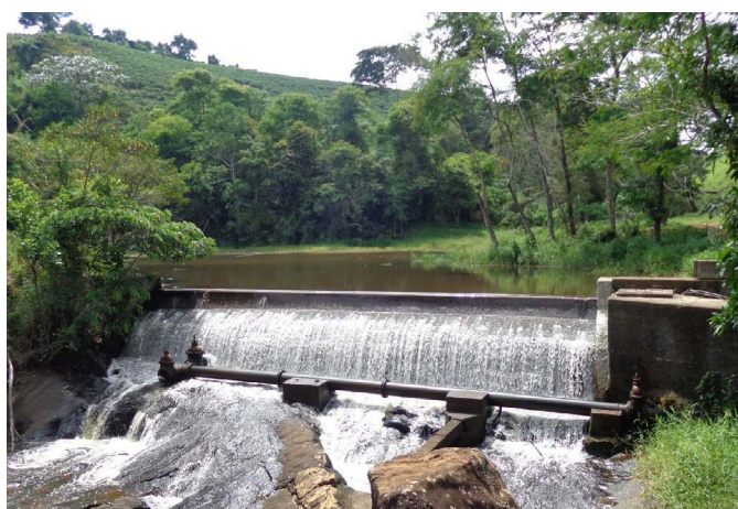
Estação de captação de água em Manhuaçu, distrito de Manhuaçu, fica abaixo e ao lado de lavras de bauxita da Mineradora Curimbaba
