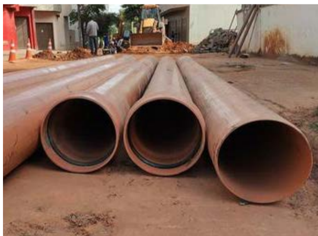
Os novos tubos de ferro fundido de cor marrom resolverão em definitivo a situação da adutora que leva água para várias residências até ao Bairro Rasa.
