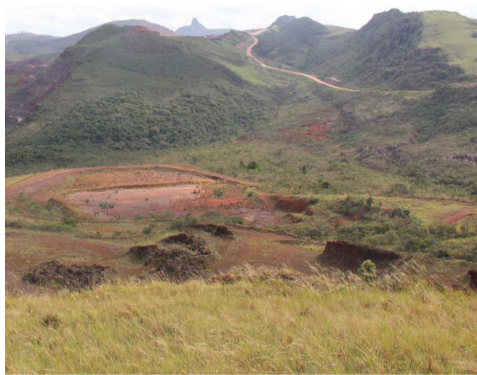
Barragem Dique 2 fica em área de Preservação Permanente (Unidade de Conservação)
