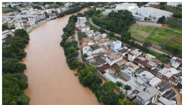
As áreas de preservação permanente nas margens do Rio Piranga estão altamente impactadas com centenas de construções que impedem o escoamento normal das águas
