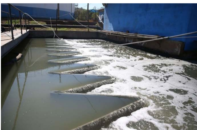
A nova lei ambiental obriga reaproveitamento de água de esgoto e de chuva
