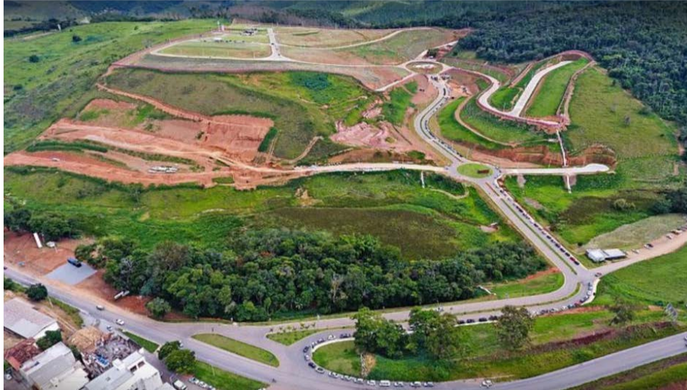
A área cedida para a construção do novo fórum de Ponte Nova fica em área de declividade acentuada, no Loteamento Estrela da Mata II
