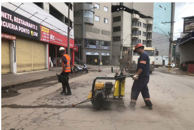
Homens trabalham com apoio do Demutran (Departamento Municipal de Trânsito)
