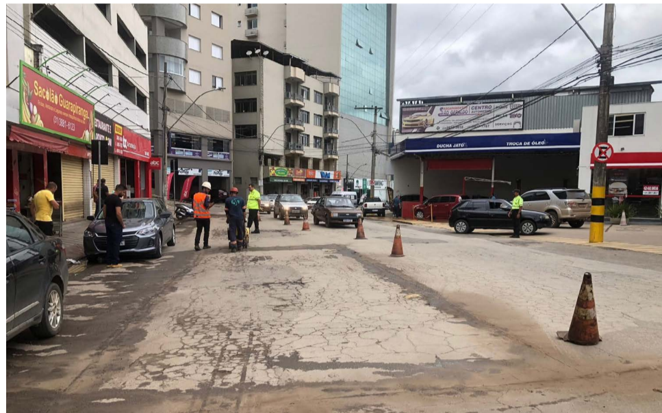
A operação tapa-buracos começou na sexta-feira, dia 27 de fevereiro, sob a supervisão da Semob, na Avenida José Grossi, Guarapiranga
