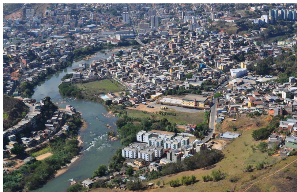
Mesmo risco de inundações, a distância para se construir nas margens do Rio Piranga diminuiu de 70 metros para apenas 15 metros
