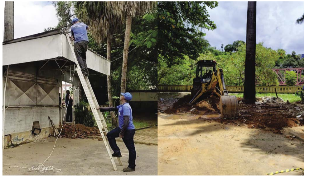
Homens da Semob desmontam o trailer para depois derrubar a estrutura de alvenaria. Horas depois o local estava vazio
