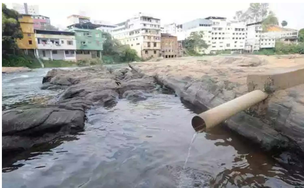
O esgoto sanitário de Ponte Nova a caminho de ser tratado, após a construção da ETE
