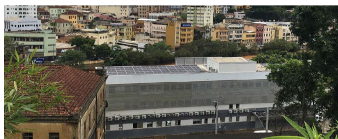
As placas solares fotovoltaicas que fornecerão energia para a Câmara estão no prédio da Sema e Sema
