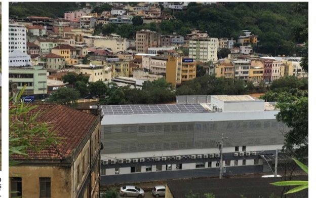
As placas solares fotovoltaicas estão instaladas nos tetos das secretarias de Saúde e Assistência Social e Habitação, no Centro Histórico
