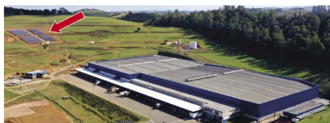
A Usina Solar do CD da Bartofil Distribuidora (seta) tem 1.200 placas fotovoltaicas e gera 70% do consumo
