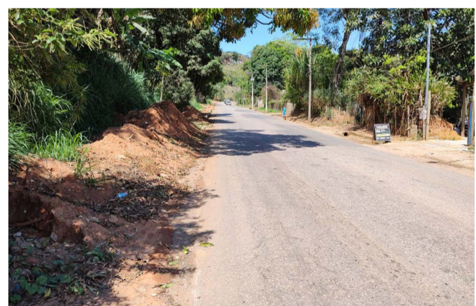
Pista de caminhada/passarela da Avenida Vereador João Evangelista de Almeida entre os bairros São Geraldo e Vale Suiço I e II foi abandonada cheia de terra
