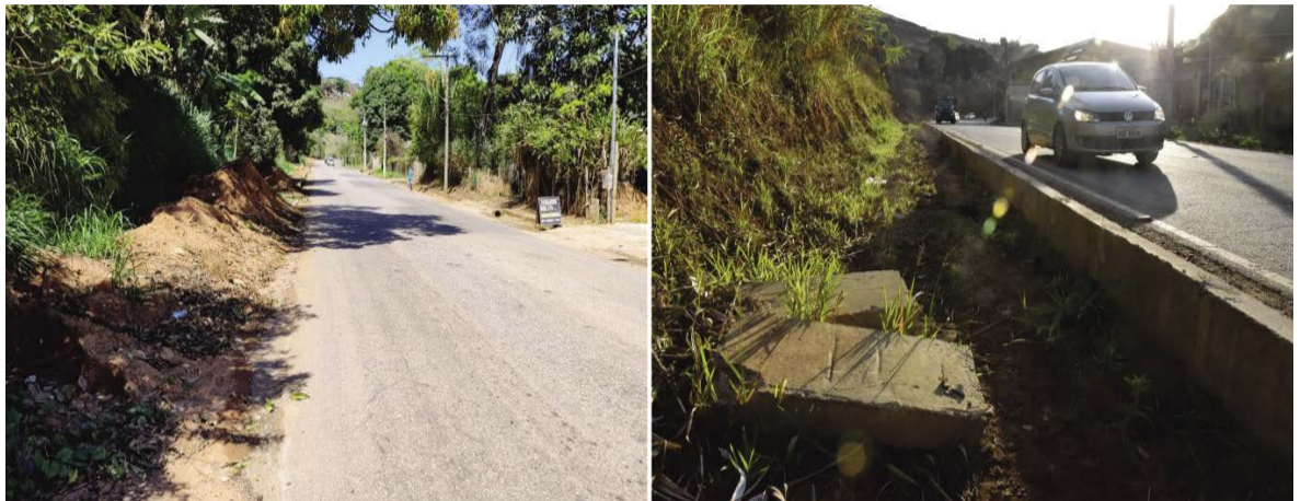
A pista de caminhada na Avenida Vereador João Evangelista de Almeida entre os bairros São Geraldo e Vale Suíço I e II está paralisada há meses e com terra amontoadá provocando lama neste período de chuvas
